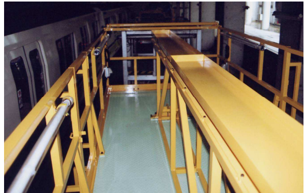
作業台&照明機器
